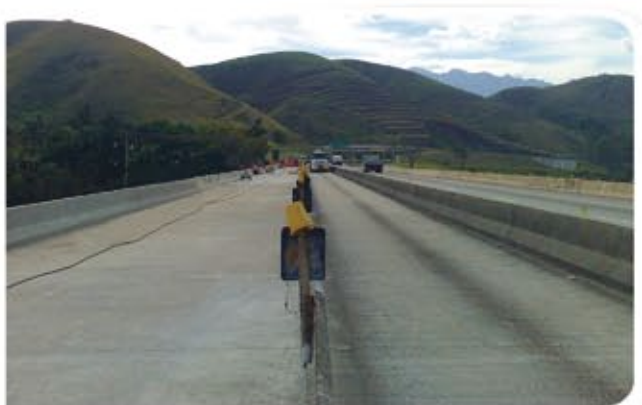
Ponte sobre o Rio Paraíba Lavrinhas-SP
